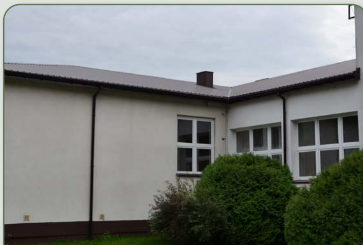
Budynek Szkoły Podstawowej w Żurawiu po wymianie dachu
