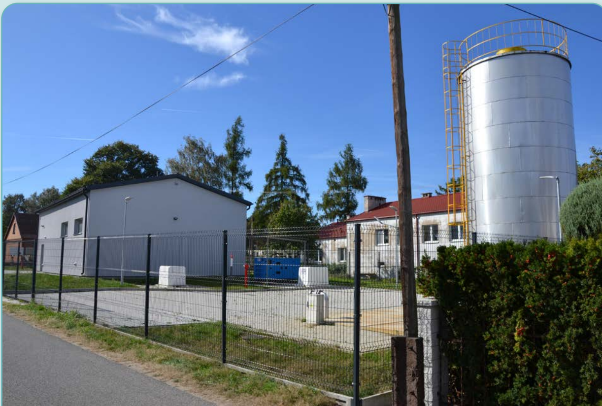
Stacja Uzdatniania Wody w Braszewicach
