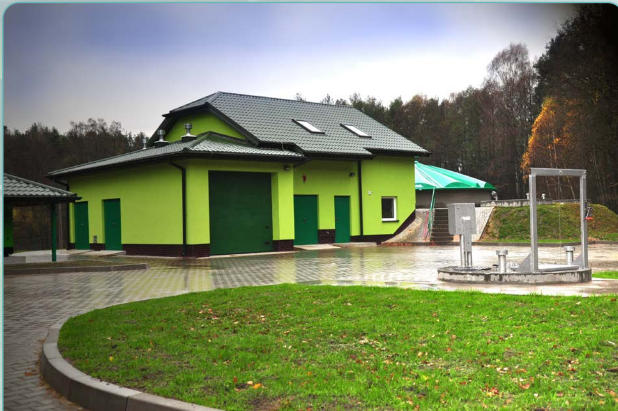
Gminna Oczyszczalnia Ścieków w miejscowości Pasie
