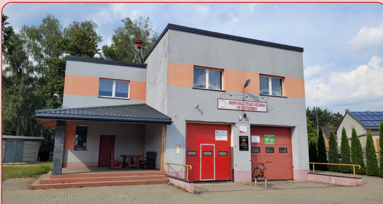
Budynek OSP Godynice po wymianie dachu
