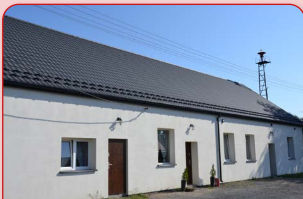
Budynek OSP Bukowiec po wymianie dachu i termomodernizacji
