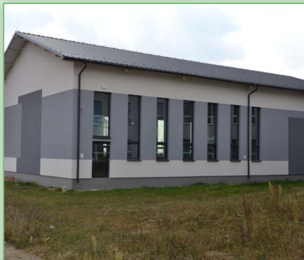
Budowa sali gimnastycznej przy Szkole Podstawowej w Godynicach
