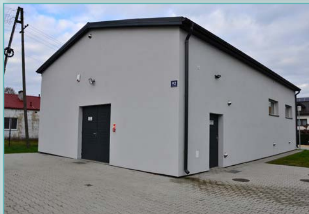
Przebudowa i rozbudowa Stacji Uzdatniania Wody w Brąszewicach
