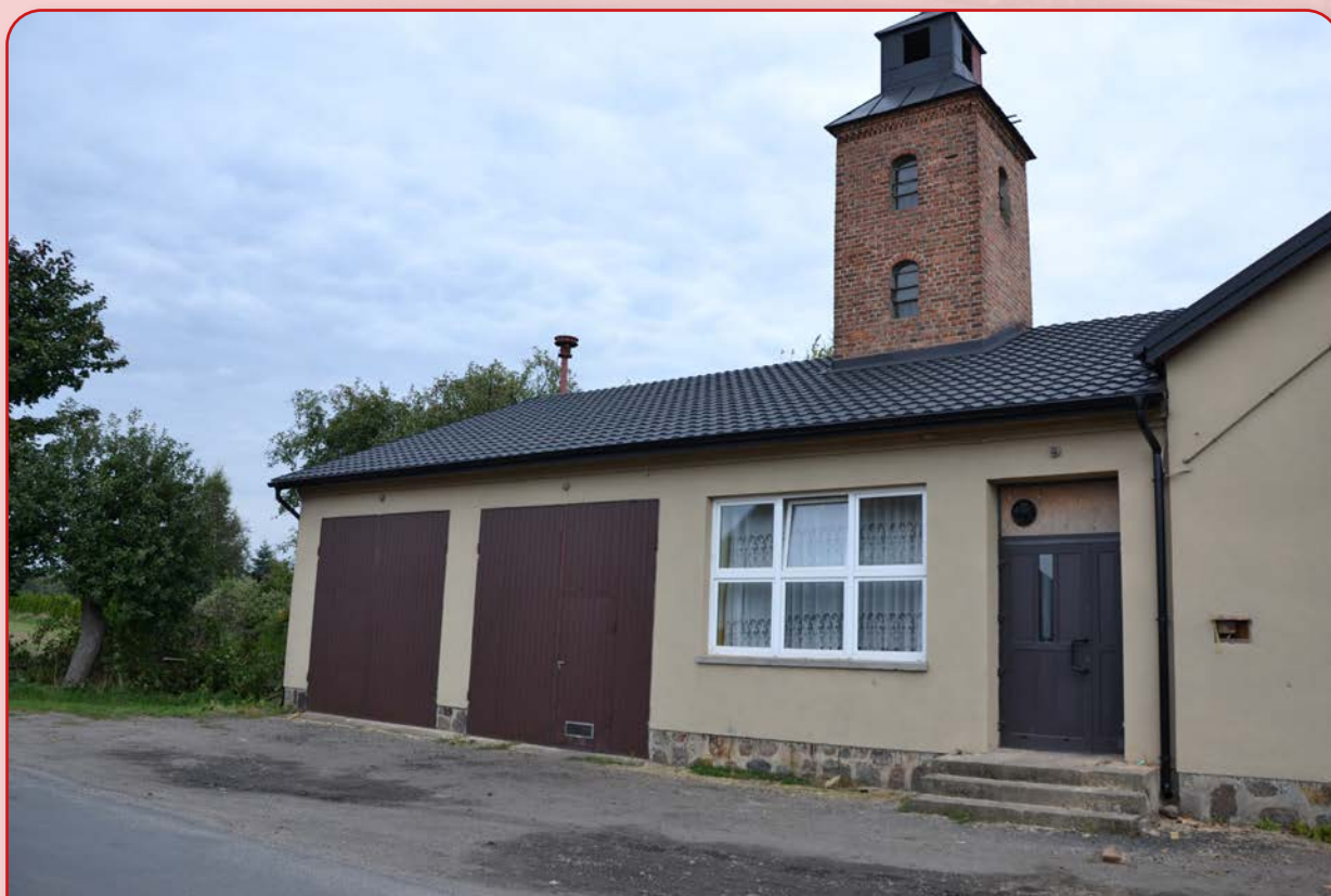
Budynek OSP Żuraw po wymianie dachu
